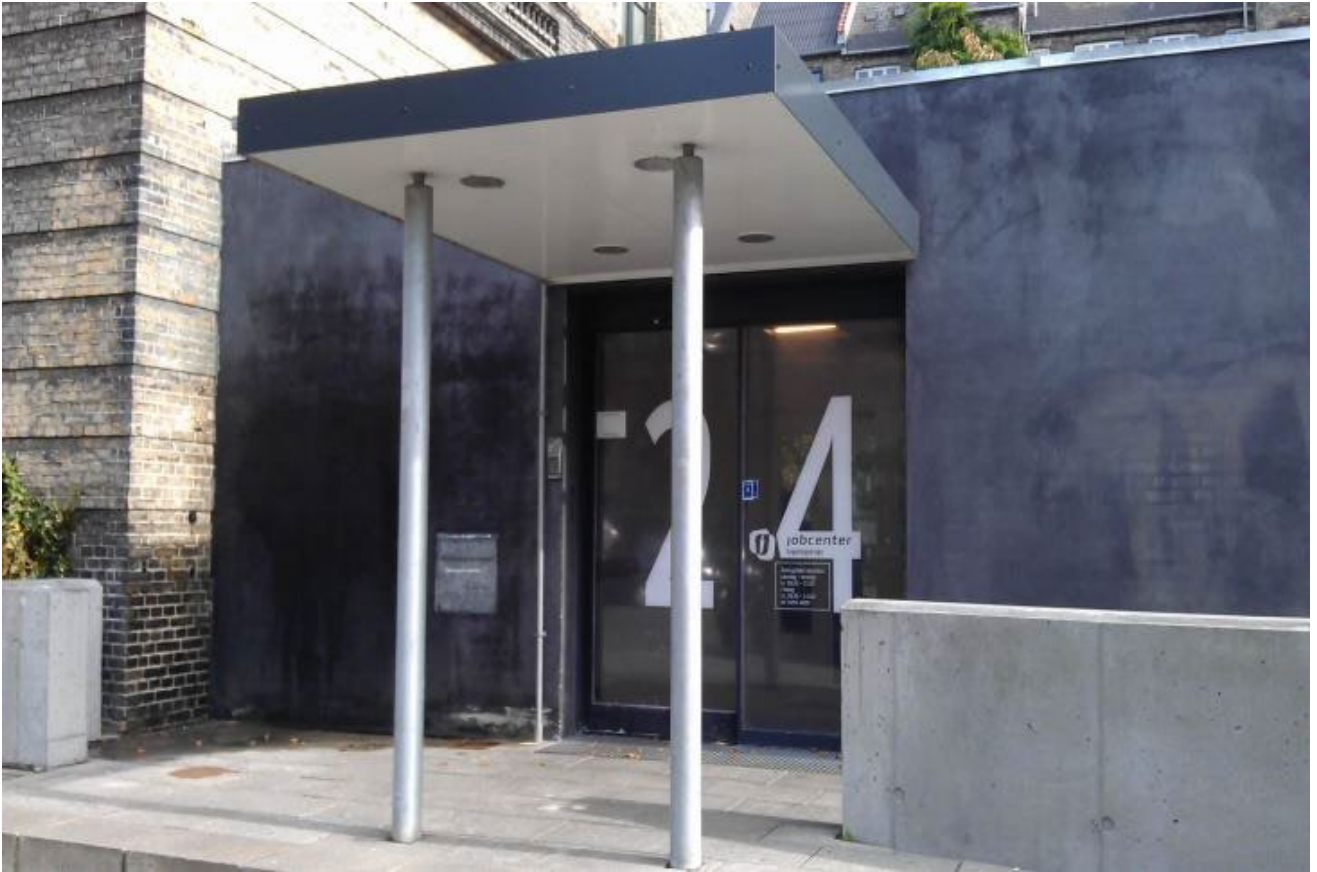
Jobcenter med niveaufri adgang via en rampe langs facaden.
